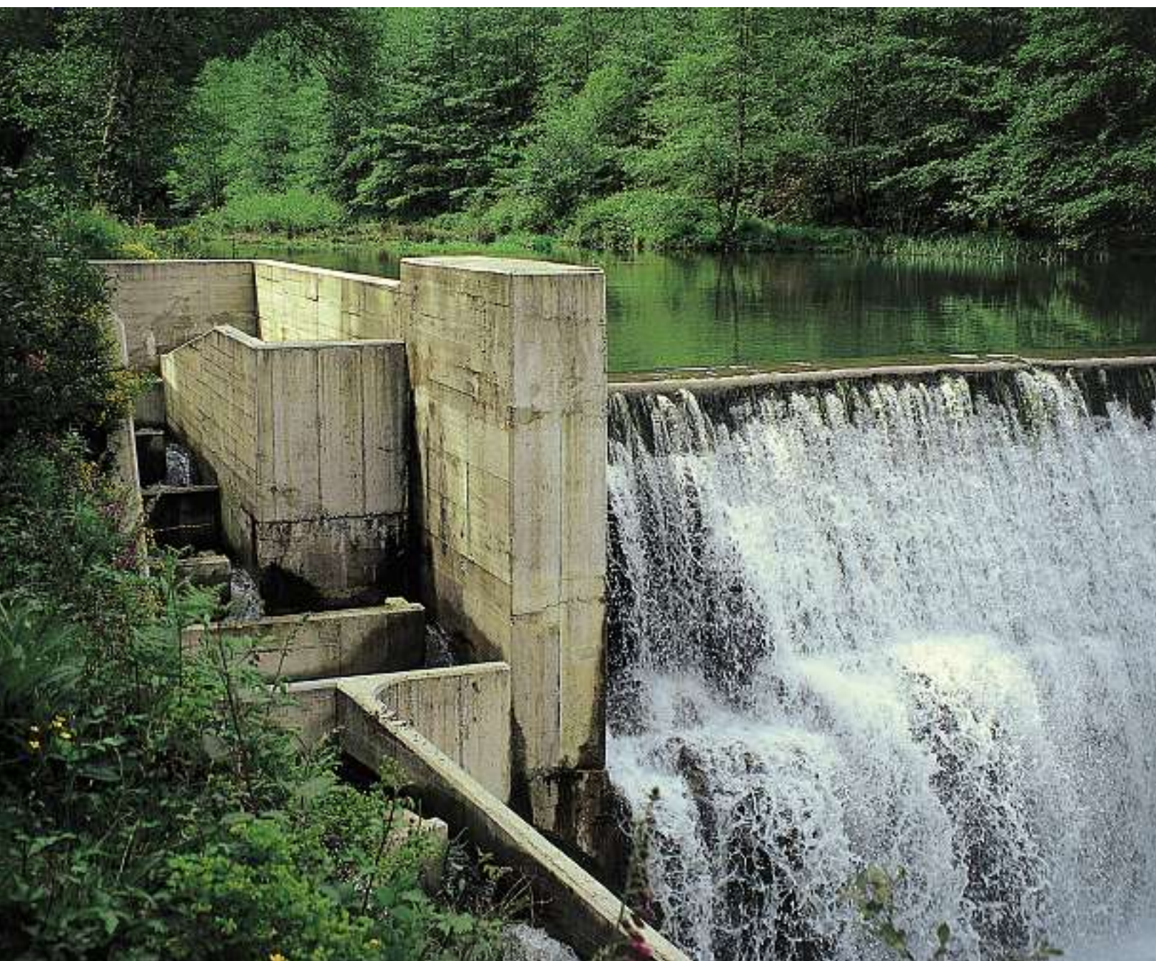
PRESA DE OLLOKI, DOTADA DE UN PASO SALMONERO, EN EL RÍO LEIZARAN (ELDUAIEN)
